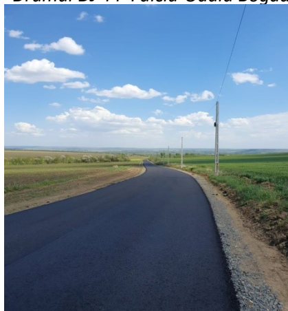
Drumul Fălcu- Copăceana
